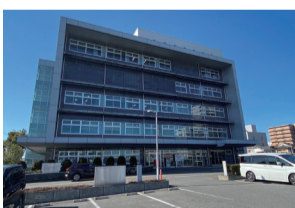
事業承継・引継ぎ支援センター 徳島経済産業会館内
