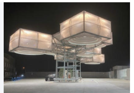
東亜合成水素ステーション
