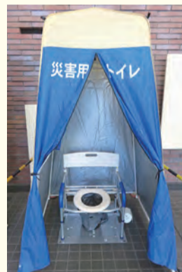
浄化槽マンホール上に設置された災害用トイレ
